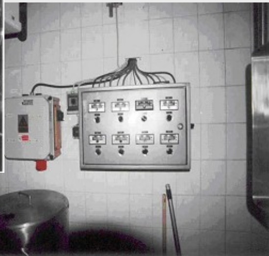
Контроль температуры танков
