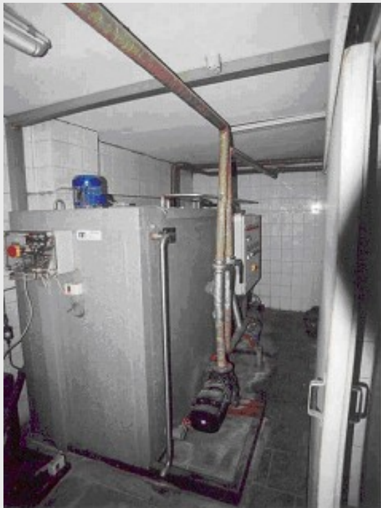
Аккумулятор ледяной воды
